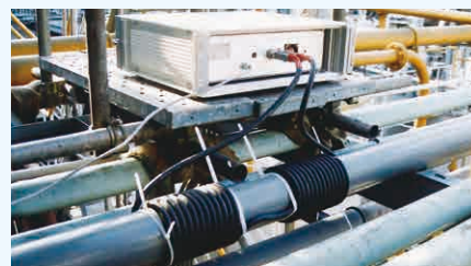
配管にコイルを設置
