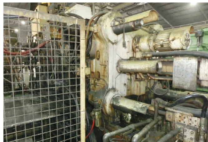
作業中のダイカスト鋳造工場
