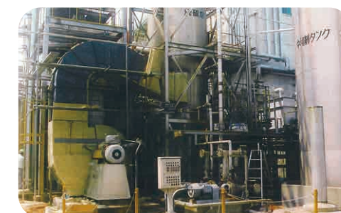
排脱ラインにSWを2台設置
