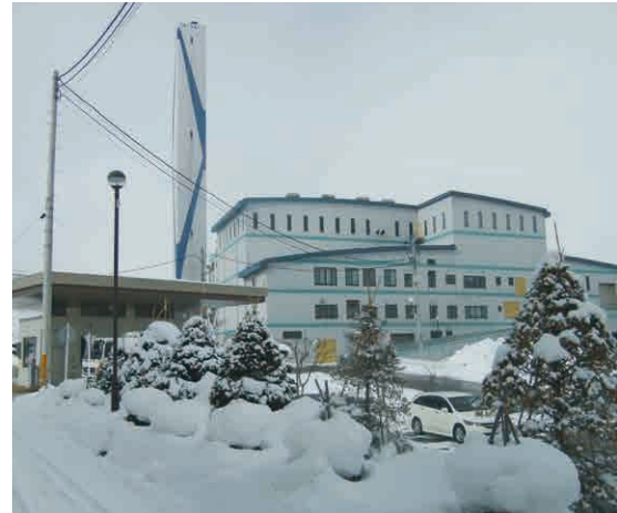
大型焼却炉 噴射ポンプ供給水に於ける設置効果
