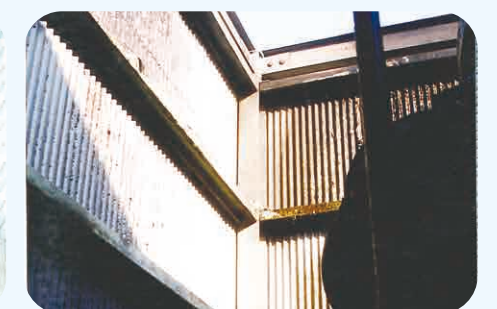
きれいになった外壁
