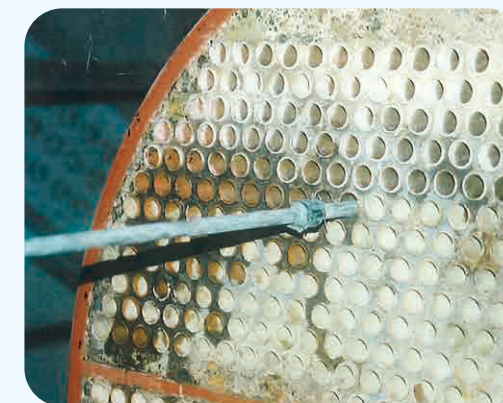
チューブ内の軟化堆積物の確認
