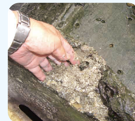
SW稼働9ヶ月後 上部皿部に軟化スケールが多量に堆積されたため 袋に回収する作業を行った
