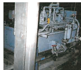
焼却炉への水の供給ポンプや配管の詰まり改善
