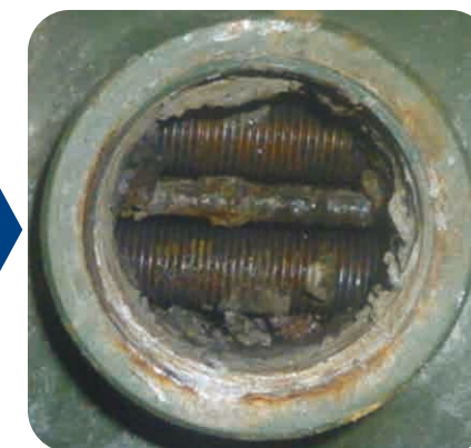
錆が軟化除去される
