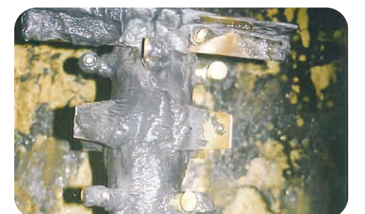
シャワーノズルの目詰り無し
