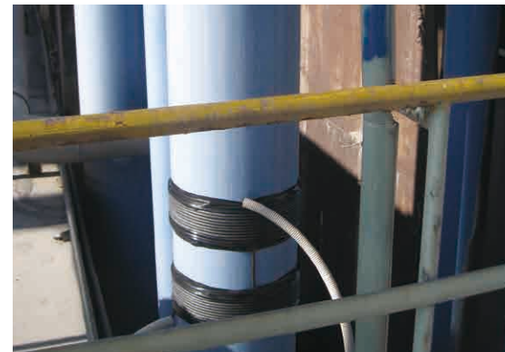
冷却水300A配管にコイル部を設置
