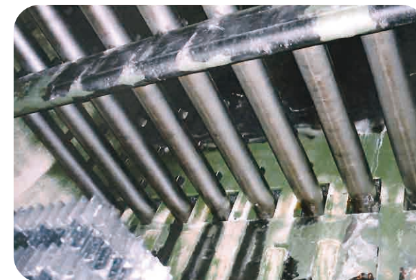
天井や配管もスケール付着無し
