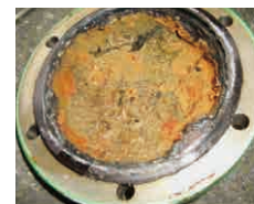
焼却炉への水の供給ポンプや配管の詰まり改善
