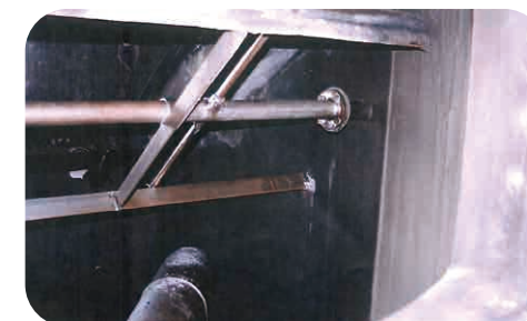
内壁部にスケール付着は無い
