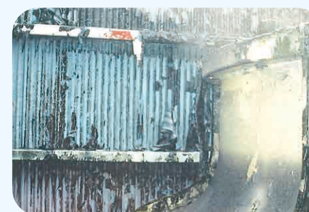
外壁から通路に剥がれ落ちたスケール
