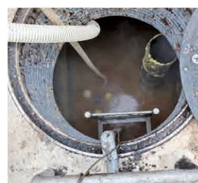
排水桝から浮上油を回収
