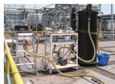
工場施設に装置をセット
