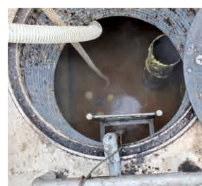
排水桝から浮上油を回収
