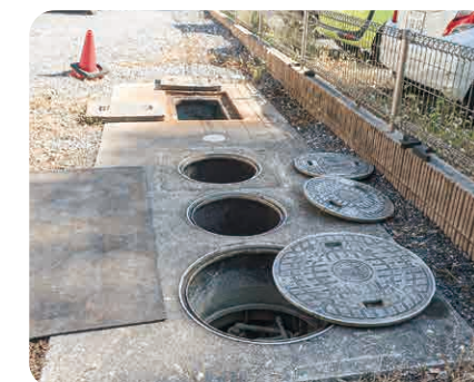
グリーストラップ内の浮上油を回収する
